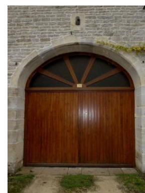
Porte pleine et imposte vitrée - Arc cintré
