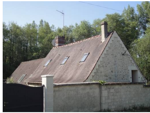
Grande rue (RD144)
