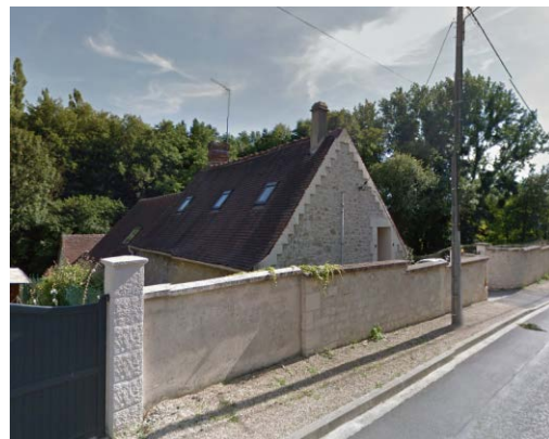
Grande rue (RD 144)
