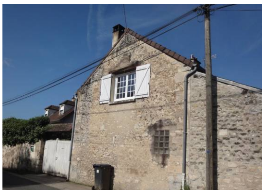
Grande rue (RD 144)
