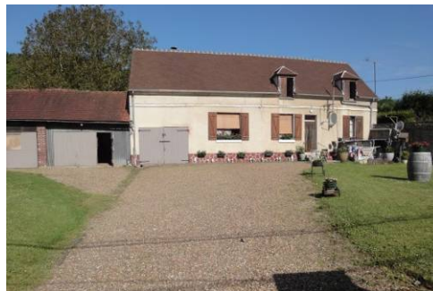
Grande rue (RD 144)
