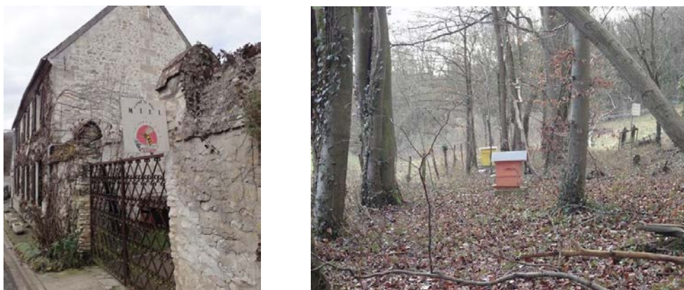
Vues depuis Grande Rue puis la Cavée d'Angy
