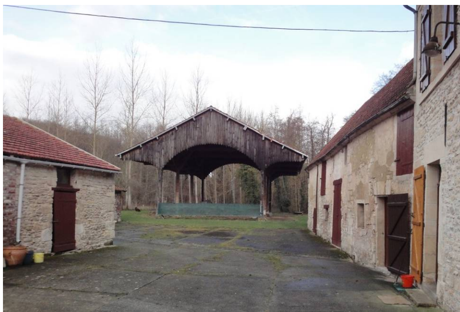
Hangar situé Grande rue.
