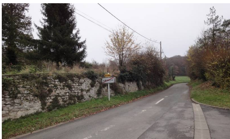
Mur situé route d'Ansacq à Neuilly-sous-Clermont
