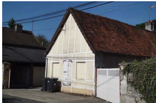
Grande rue (RD144)
